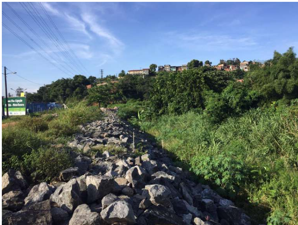
Figura 9 – Trecho T10 com obras de enrocamento de pedras em execução
