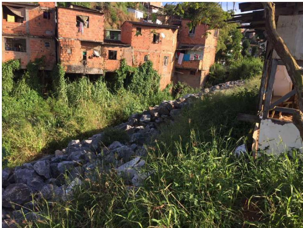
Figura 8 – Trecho T10 com obras de enrocamento de pedras em execução
