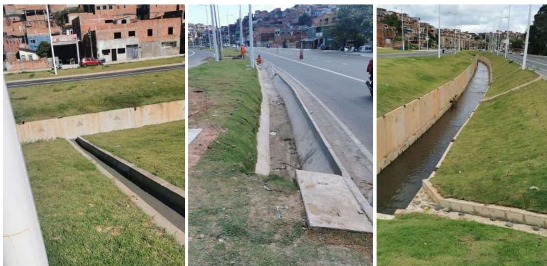
Figura 8 – Execução dos serviços de campo na Av. Gal Costa
