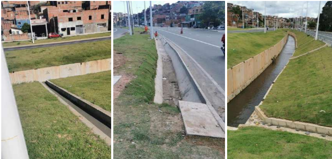
Figura 8 – Execução dos serviços de campo na Av. Gal Costa
