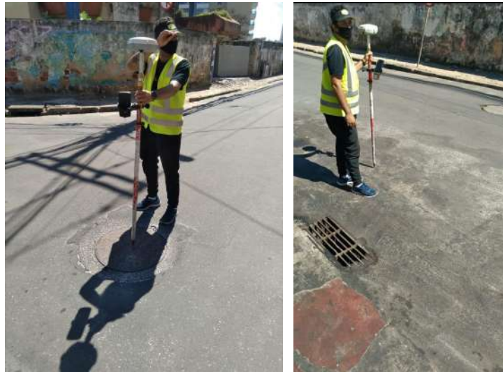
Figura 9 – Execução dos serviços de campo no bairro de Pituçu
