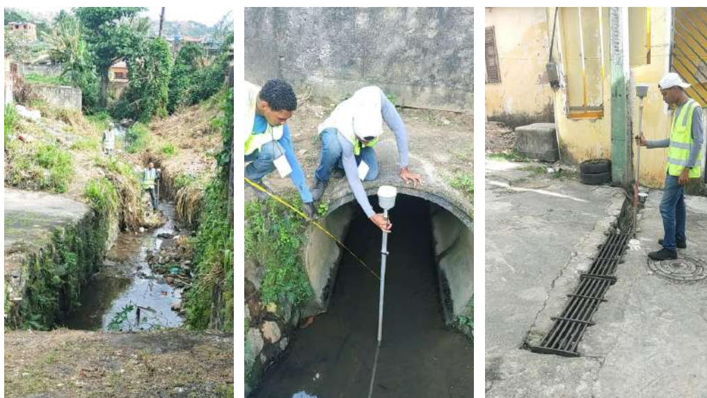
Figura 9 – Execução dos serviços de campo no bairro de Coutos
