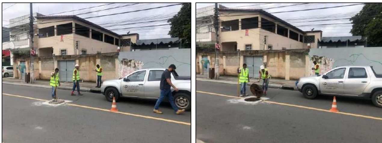
Figura 7 – Execução dos serviços de campo com sinalização da via e abertura de poços de visitas – Av. Dendzeiros do Bonfim
