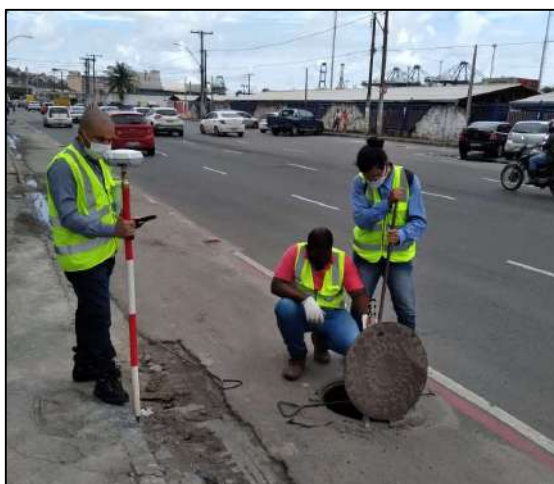
Figura 8 – Execução dos serviços de campo com abertura de poços de visita – Av. Engenheiro Oscar Pontes
