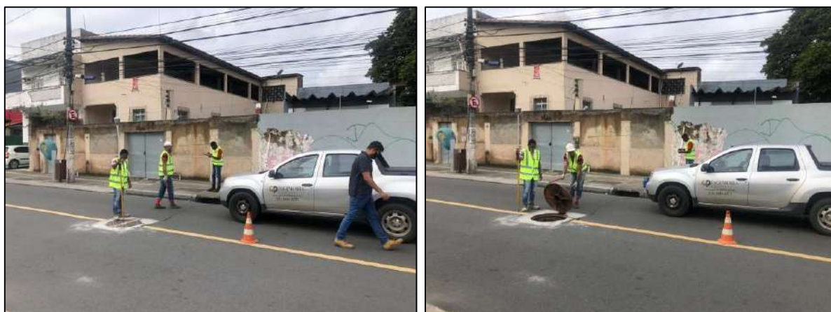
Figura 7 – Execução dos serviços de campo com sinalização da via e abertura de poços de visitas – Av. Dendezeiros do Bonfim
