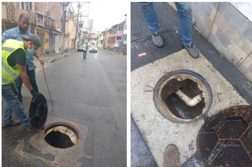
Figura 9 – Execução dos serviços de campo na rua São Gonçalo em São Gonçalo do Retiro
