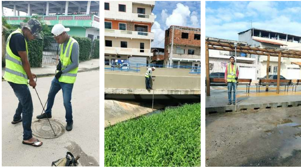
Figura 10 – Execução dos serviços de campo no bairro de Periperi
