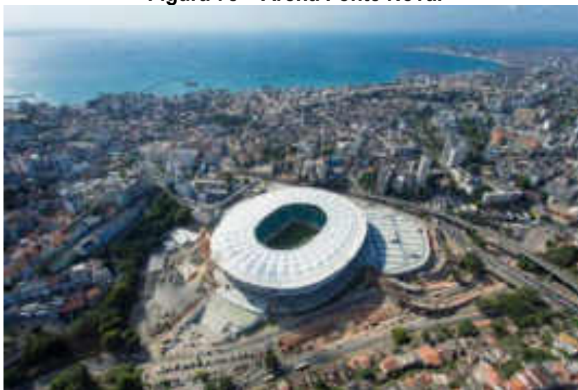
Figura 78 – Arena Fonte Nova.
