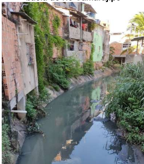
Figura 126 – Ligações clandestinas de esgoto diretamente no Rio Pernambués, na bacia do rio Camarajipe
