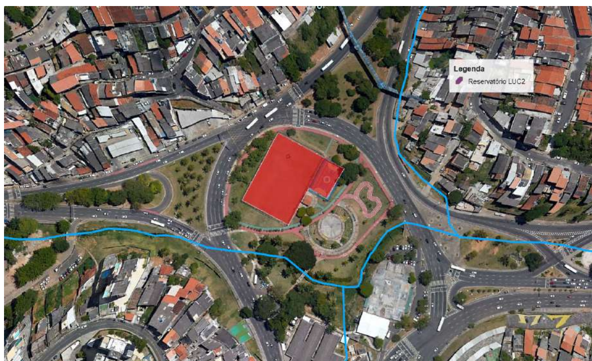
Figura 59 – Reservatório LUC 2, Praça Dr. João Mangabeira
