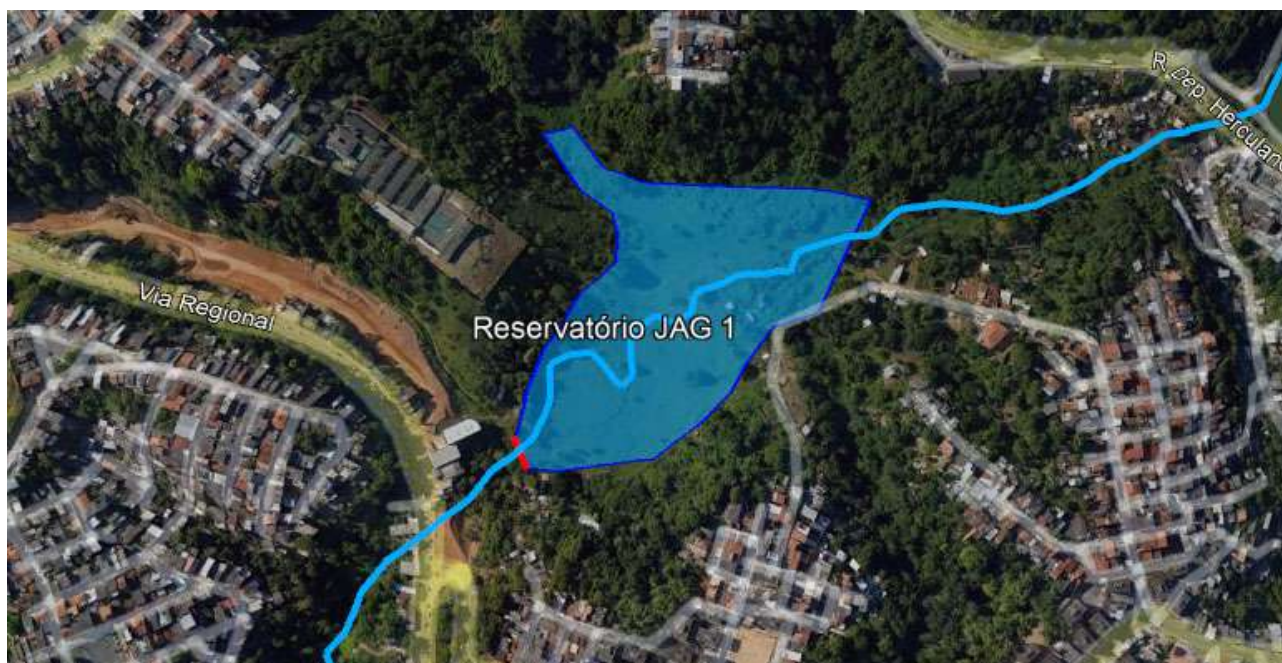
Figura 46 – Reservatório JAG 1, no rio Cabo Verde
