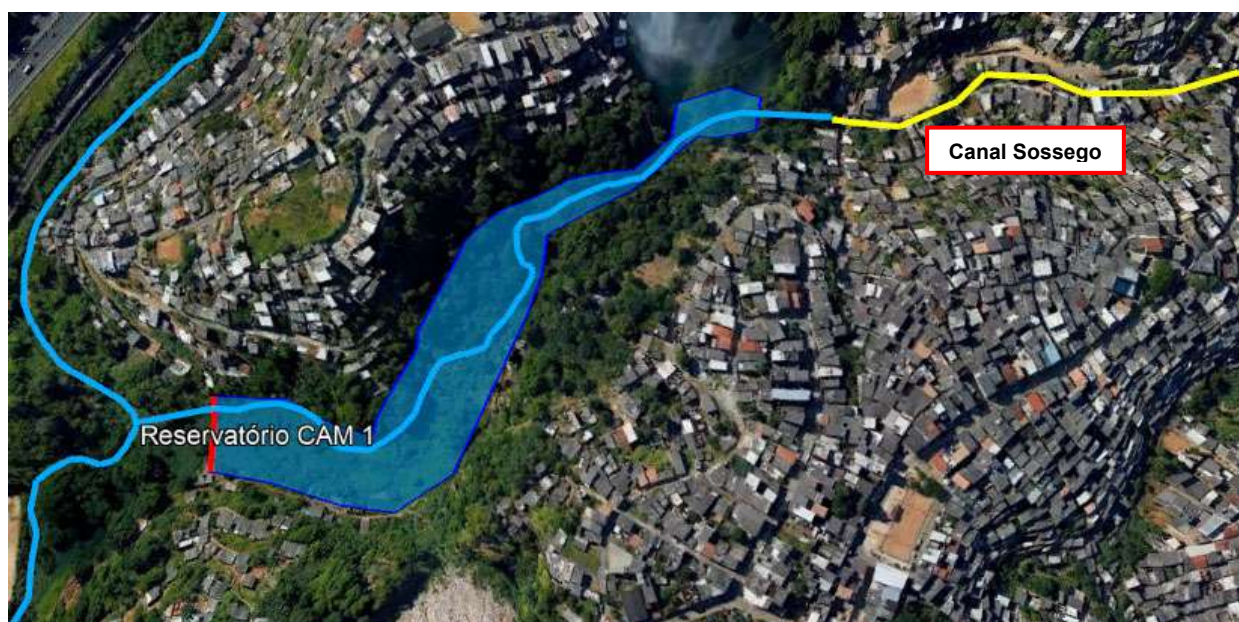
Figura 26 – Reservatório CAM 1, Barragem Mata Escura
