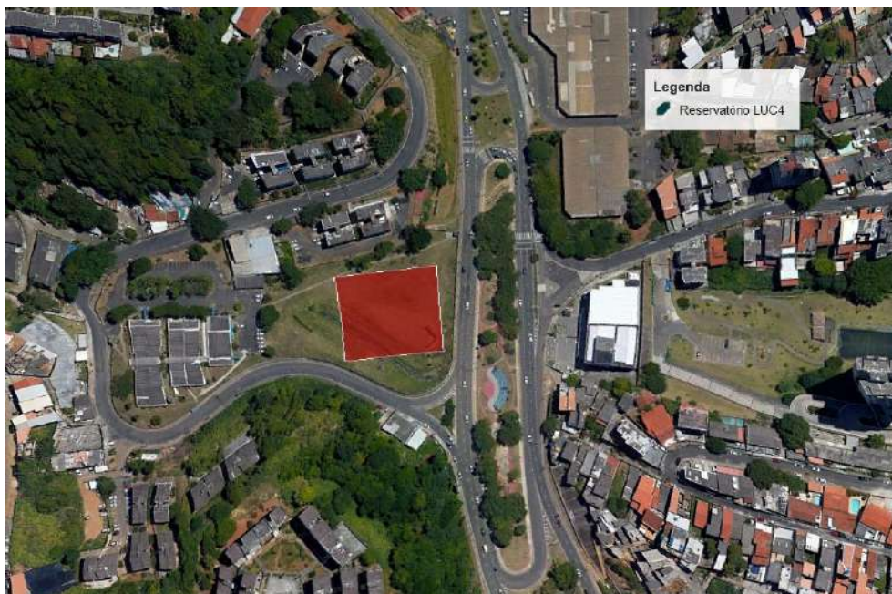
Figura 61 - Reservatório LUC 4, Área livre do CREA/BA
